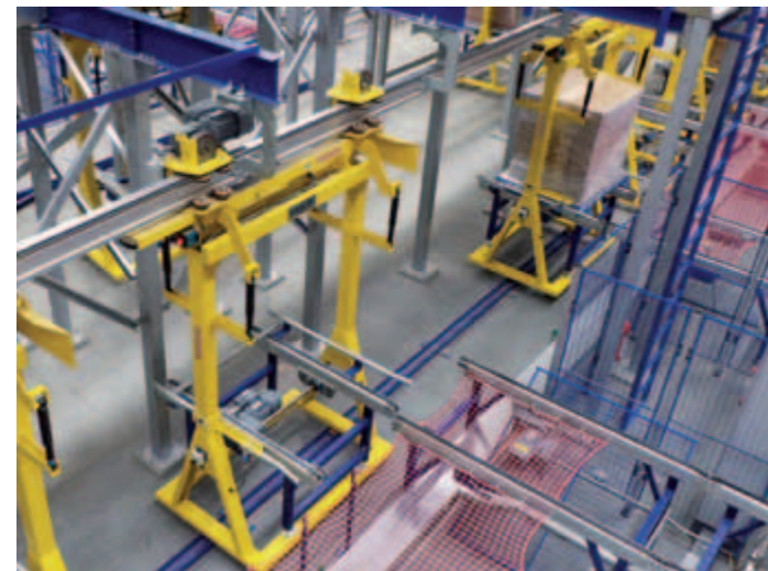
Die mit 24 Fahrzeugen bestückte Einschienenhängebahn verbindet die periphere Fördertechnik mit dem Hochregallager und ist bis zu 150 Meter pro Minute schnell.
